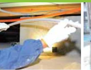
床下にもぐってガス管を伸ばし、リビングに取り付けたガス栓につなぎます。
