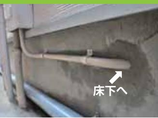
S様邸では、屋外配管から分岐したガス管を床下に通しました。使用するガス管(フレキ管)は自由に曲げることができます。
